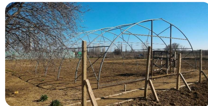
Процесс монтажа теплиц (работы выполнены в прошлом году)
