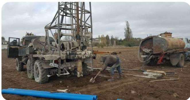
Скважина (работы выполнены в прошлом году)
