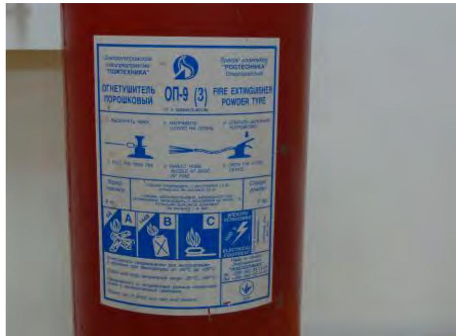
Работоспособность огнетушителя подтверждена паспортом завода-изготовителя на корпусе. Давление в пусковом баллоне в зеленом секторе говорит о готовности к эксплуатации.
