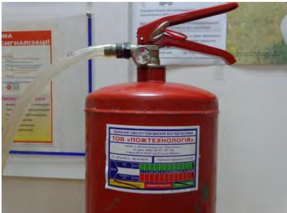
Указанный огнетушитель прошел техническое обслуживание, содержится надлежащим образом, имеет маркировку о прохождении технического обслуживания, учетный инвентарный номер
