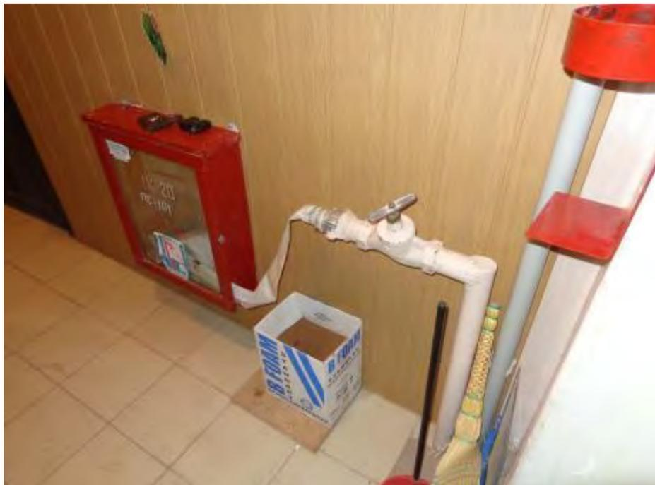
шкаф пожарного крана установлен неверно.
