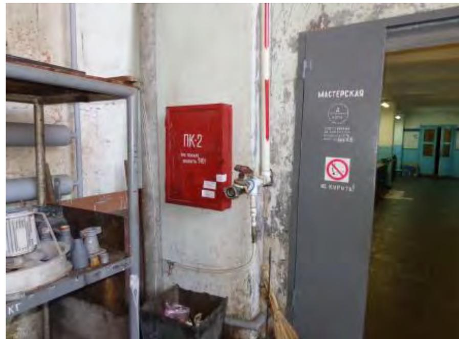
Рукав пожарного крана должен быть подсоединен к полугайке пожарного крана. Труба, на которой установлен пожарный кран, должна быть стальной
